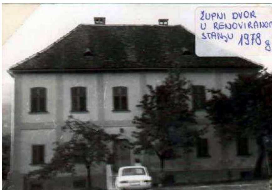
Župni dvor nakon obnove 1978.
