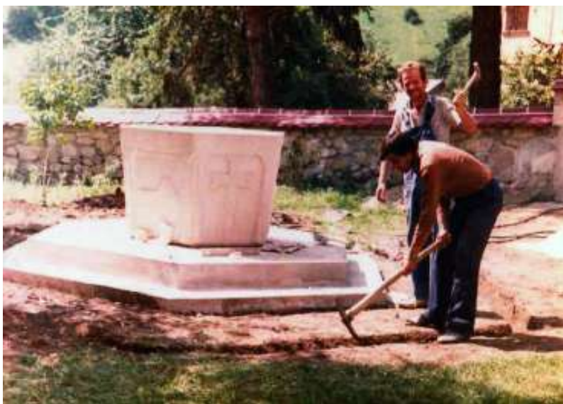
Radnici koji su radili betonske radove pri izradi krstionice
