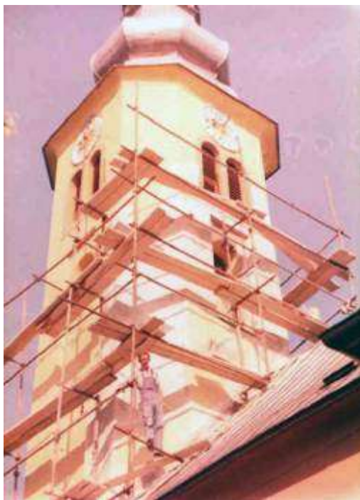
Obnova fasade tornja 1985. god.
