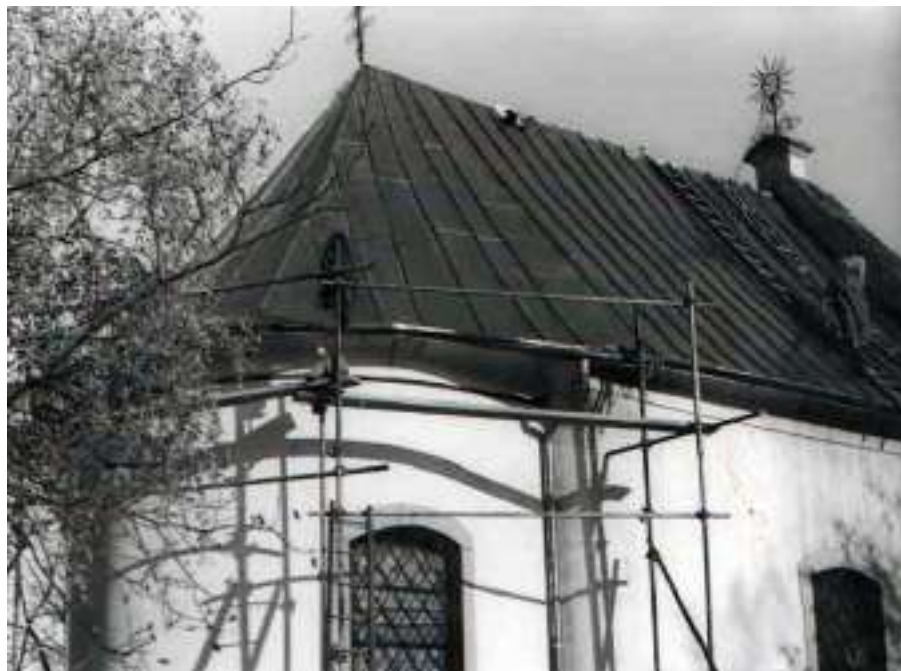
Radovi na krovu kapele 1980.
